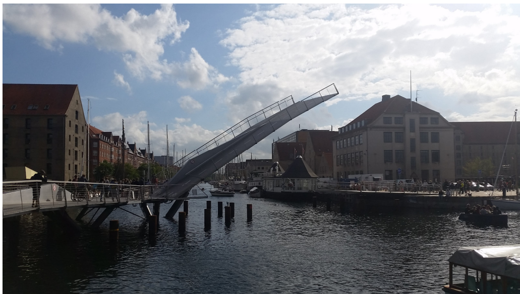
Neue Klappbrücke nach Christianshavn, Kopenhagen.
